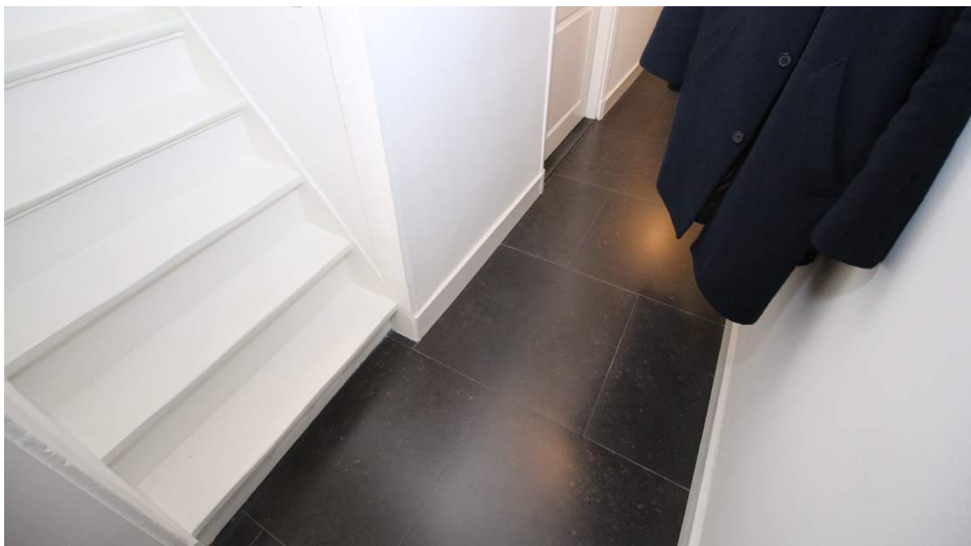
De gang, gezien richting de achtergevel (linksboven) en de voorgevel (rechtsboven) Onder de vloer met aansluiting van de trap, plinten en binnendeur
