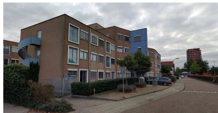
Transformatie kantoor naar wonen – Stationsweg, Heerenveen 2
