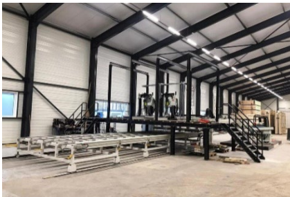
Pre-fab bouw IIBO
