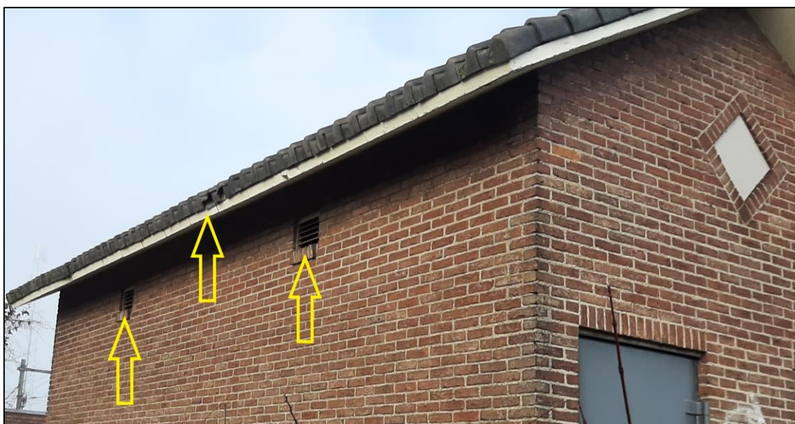
Figuur 3.1 Voor vleermuizen geschikte openingen in het te slopen schakelstation. Bron foto: Ecogroen.
