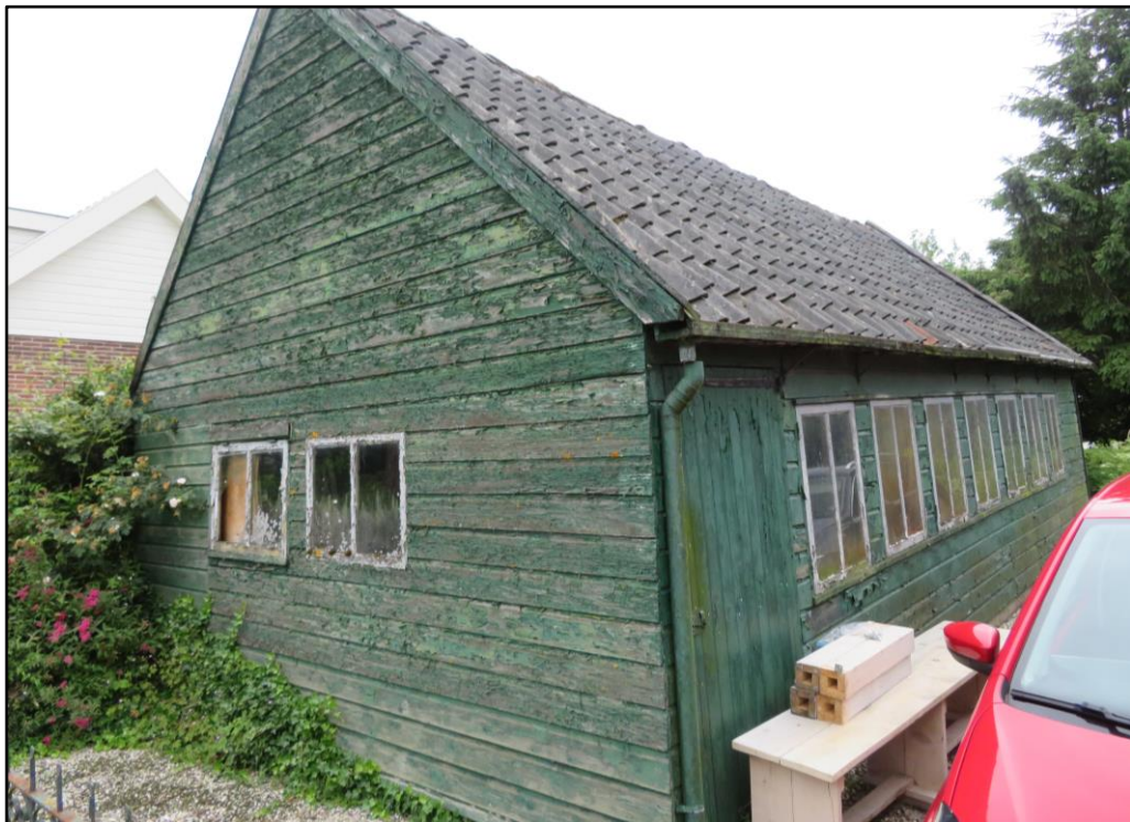
Figuur 4 De te saneren schuur.
