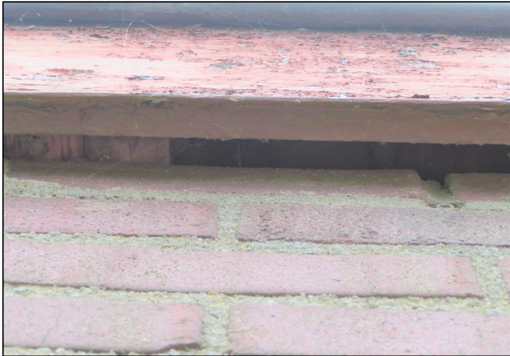
Figuur 4 Geschikte invliegopening naar de spouwmuur.
