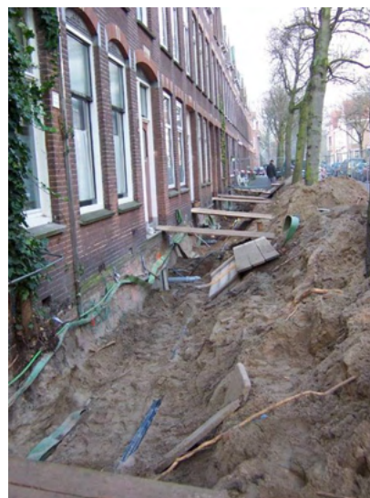
Figuur 6: Werk aan kabels en leidingen.
