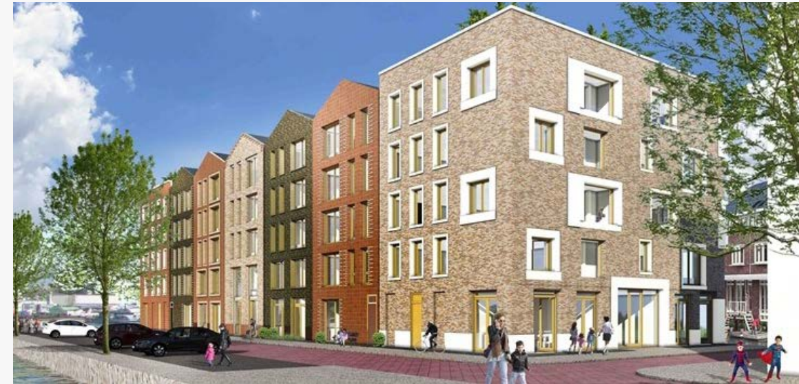
Twee voorbeelden van aangebrachte geleiding in het gevelbeeld, het toepassen van verschillende dakrand beëindigingen, en het gebruik van baksteen in meerdere kleurtonen.
