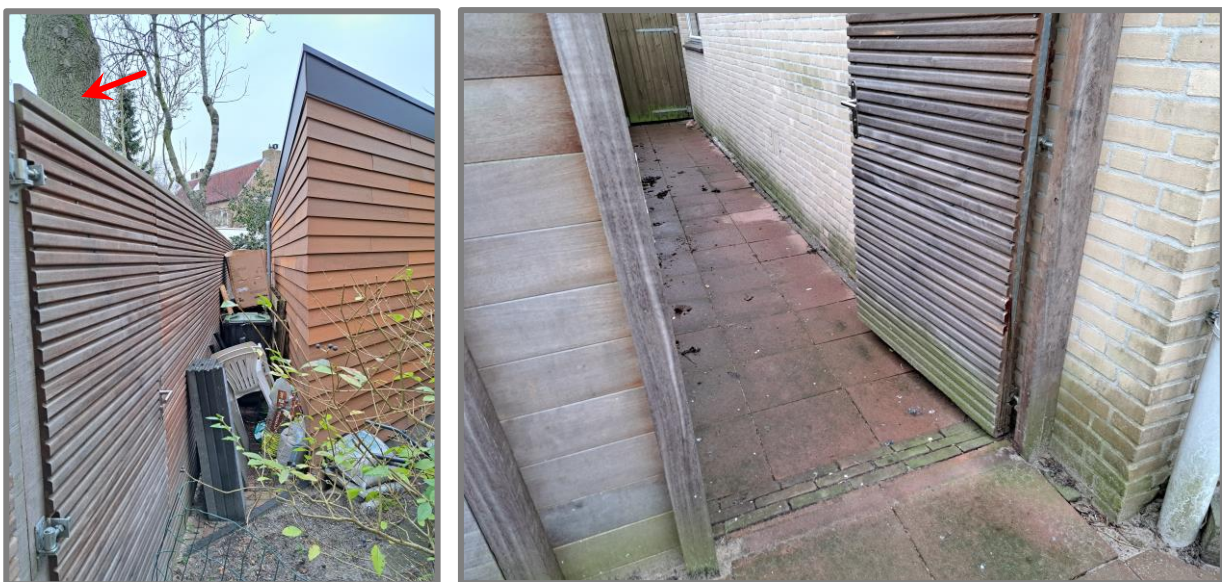
Fig. 3: In het deel waar nu de schuur op het perceel Stokroos 16 staat (links), zijn tijdens de bouw zeer veel dikke boomwortels verwijderd. Daardoor is de levensverwachting van de boom sterk afgenomen. Het uitgraven van een ca. 1,5 meter diepe sleuf langs de fundering, het doorzagen van de boomwortels en het plaatsen van een kunststof wortelscherm is hier geen geschikte optie (rechts). Het kappen van de boom is daarom het enige wat de wortelgroei in de kruipruimte kan stoppen.
