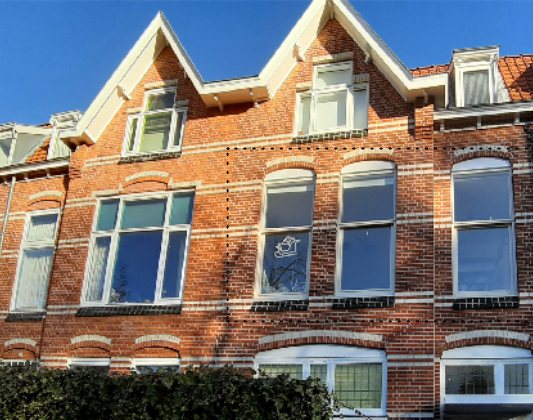
FOTO: BESTAANDE TOESTAND 1E VERDIEPING
