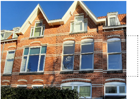
FOTO: BESTAANDE TOESTAND 1E VERDIEPING
