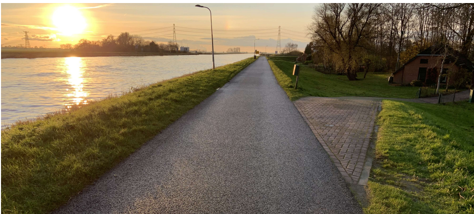
Figuur 3-1: Eemskanaal Noordzijde nabij Groevesluis
