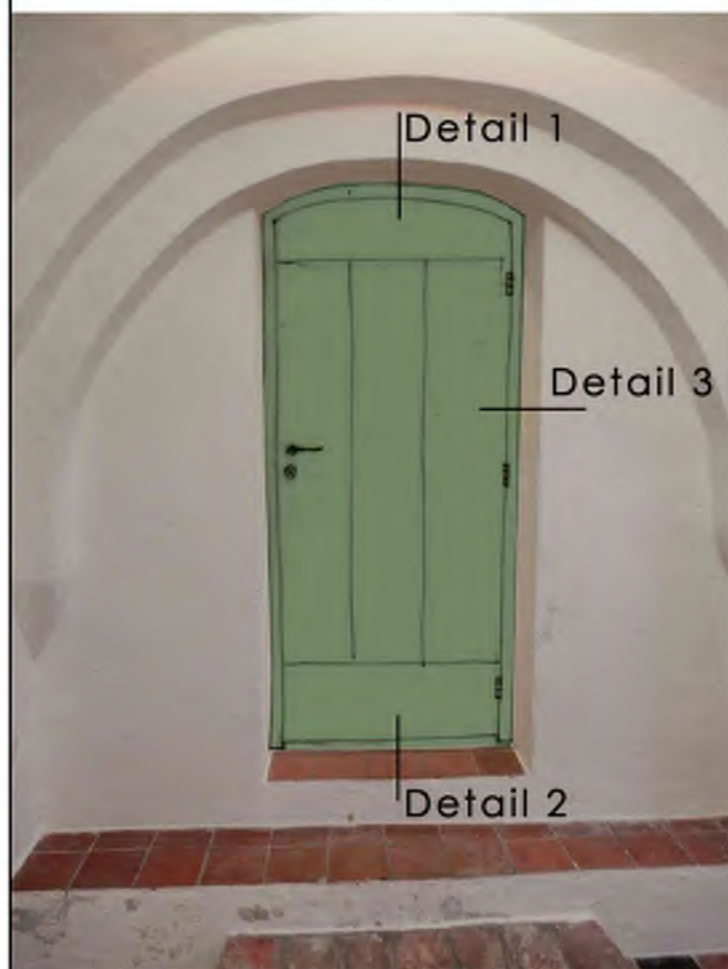
Nieuwe brandwerende deur en kozijn
