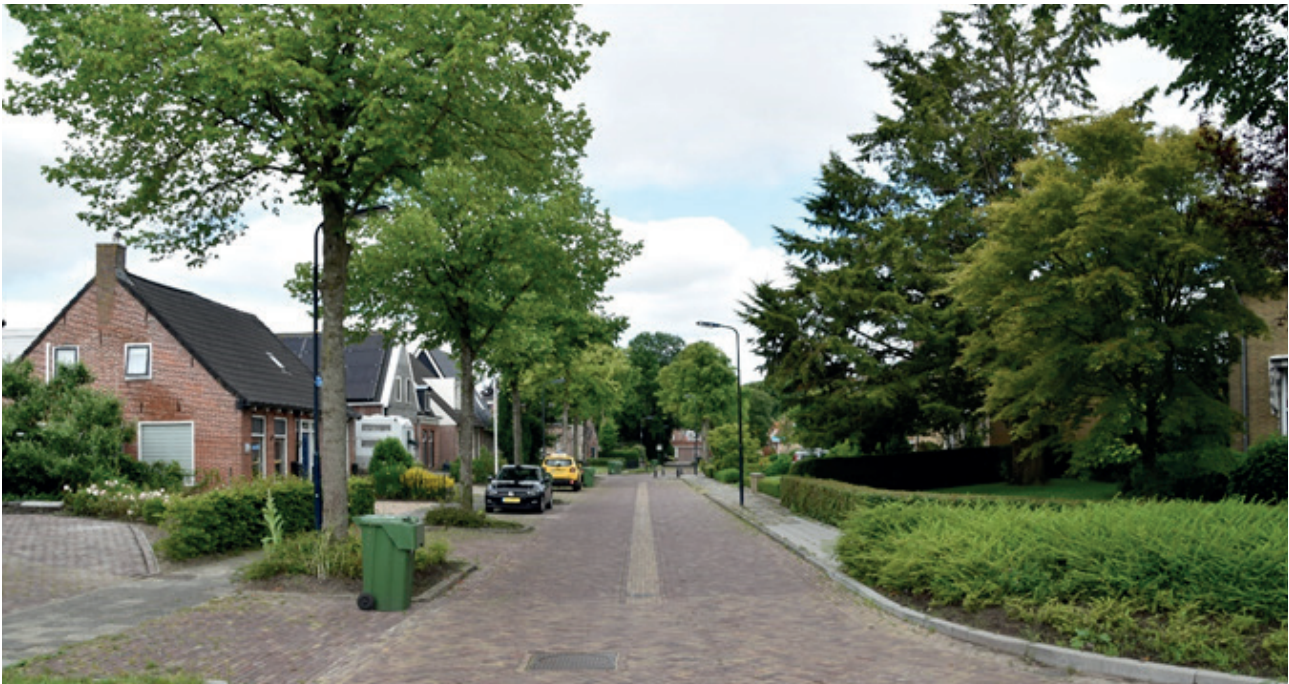
Figuur 6: Vergroten van waterberging door middel van een hol straatprofiel, Kakewei Stiens
