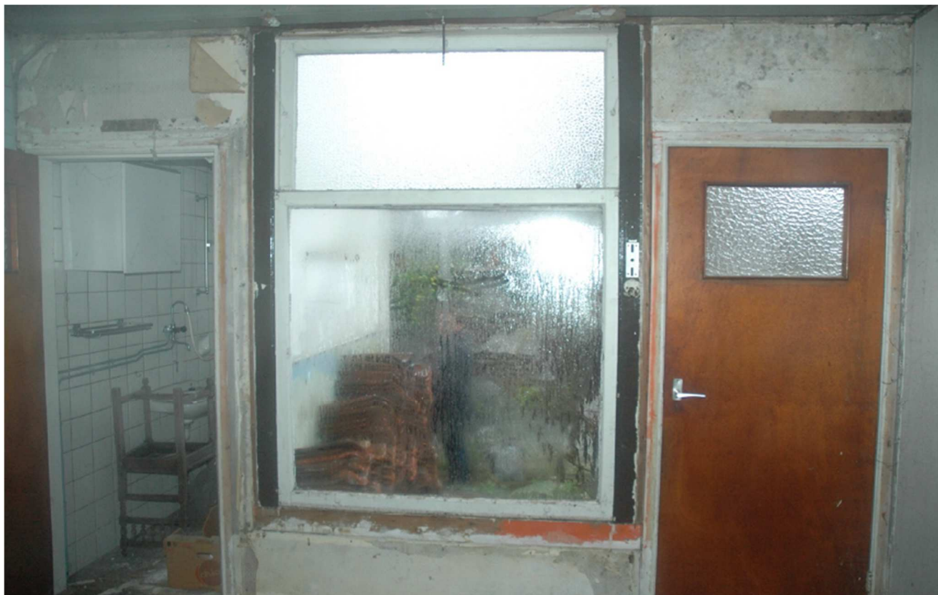
zicht naar uitbouw keuken en geveldeel uit 1954
