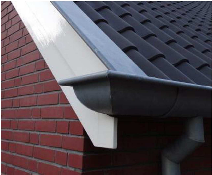
Principe beëindiging bakgoot
