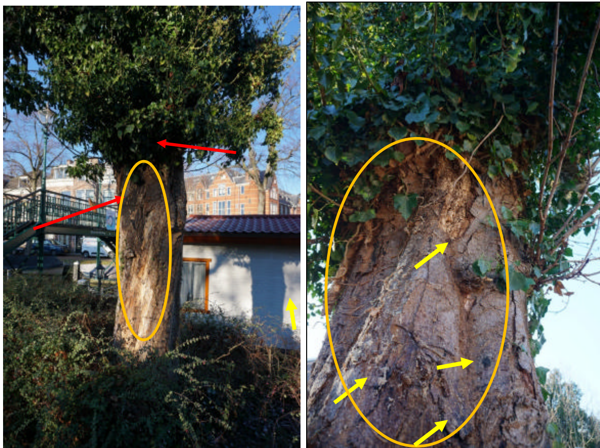
Foto 2 en 3: Links een foto van de stam, de mechanische beschadiging is indicatief aangegeven met oranje lijn. De rode pijlen geven aan waar de holten zich in de stam bevinden. Rechts een detailbeeld van de stam. Gele pijlen geven oude en nieuwe kastanje bloedingsvlekken aan. De oranje ovaal geeft indicatief de holte en houtrot in de kroonbasis aan.
