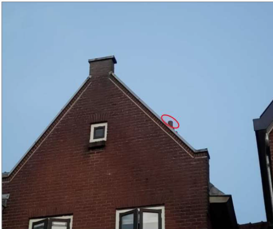
Afbeelding 2.1 | Gierzwaluw nest locatie, achterkant van de Rozenstraat 16. Hoewel niet goed te zien op de foto, bevindt het nest zich aan de rechterzijde op het dak onder de dakpannen bij de ventilatie pijp.
