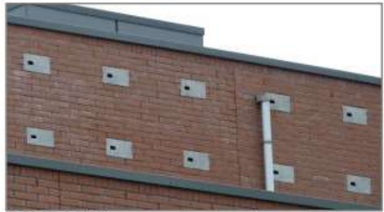
IB GZ 03 of 05 inbouwstenen in een gevel
