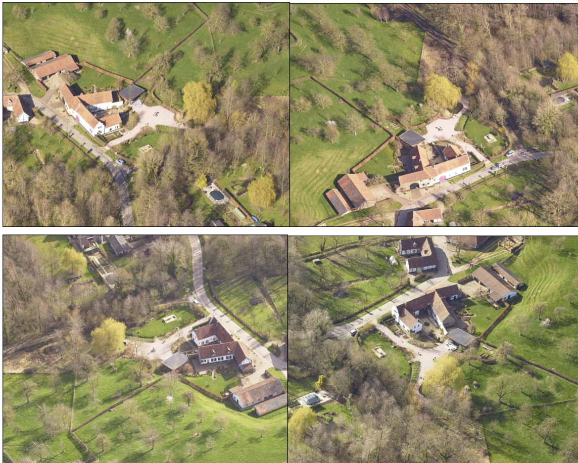
Foto's bestaande situatie
