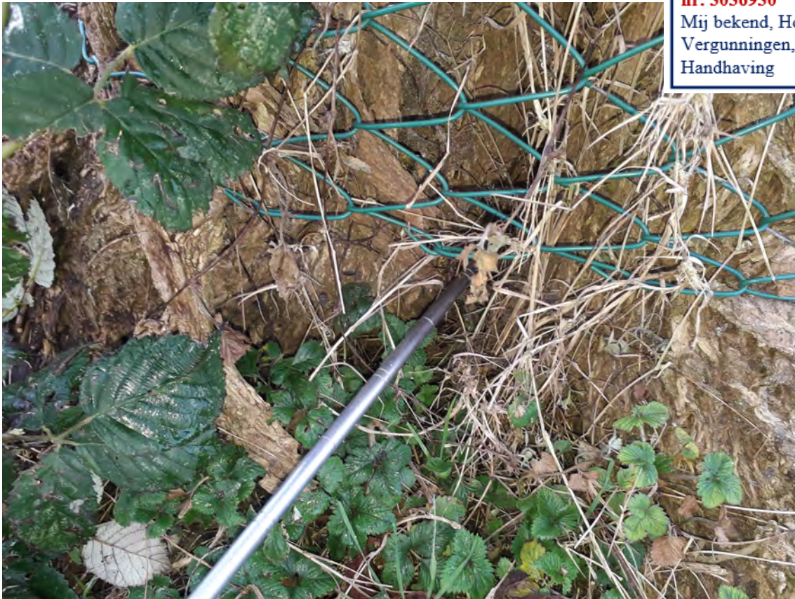
Figuur 6: Beginnende rotting in de stamvoet aan de trekzijde
