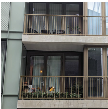
inpendige balkons als uitsparingen in de gevel
