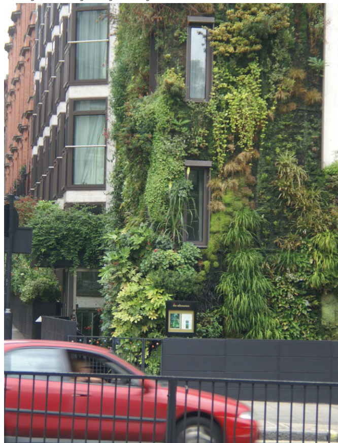
Groene gevel met hoogwaardig afwerkingsniveau
