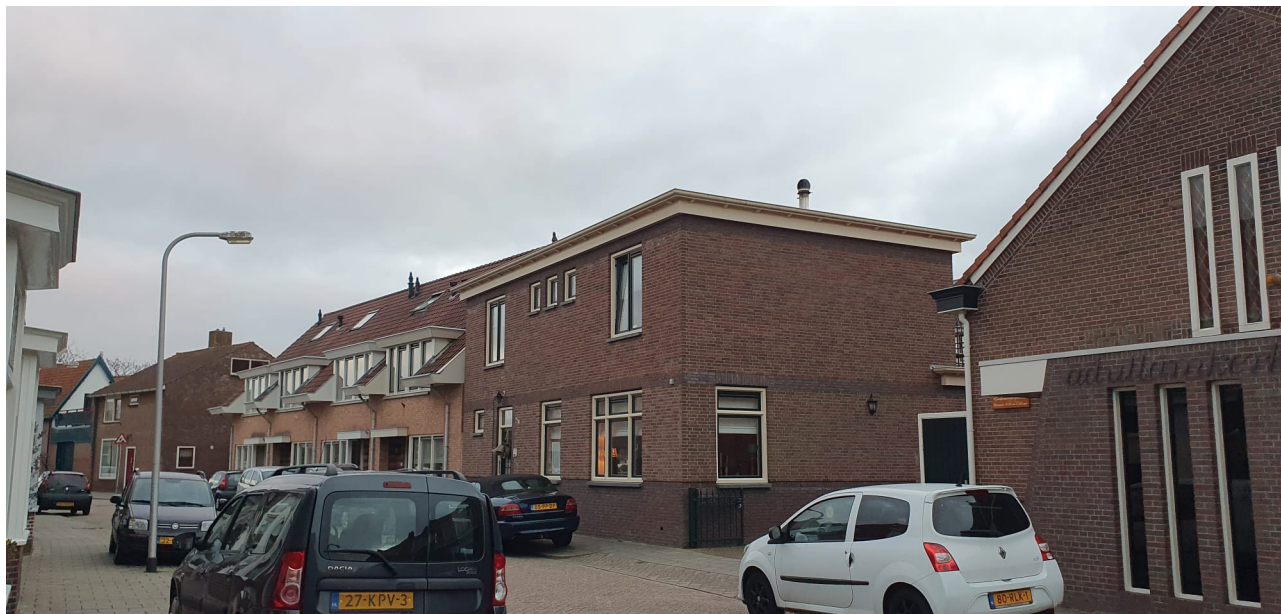
Foto bestaande voor/ zijgevel
