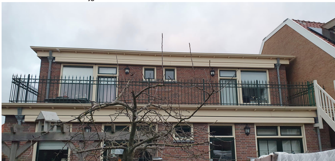
Foto bestaande achtergevel
