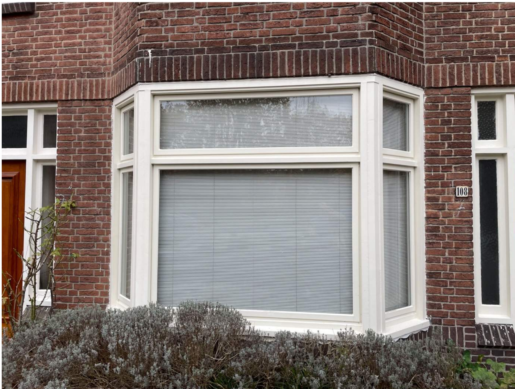
Nieuwe kozijnen in samenhang met ensemble: traditionele houten kozijnen met (eenvoudige) profilering. Foto's van bestaande kozijn detaillering Lammenschansweg 108.
