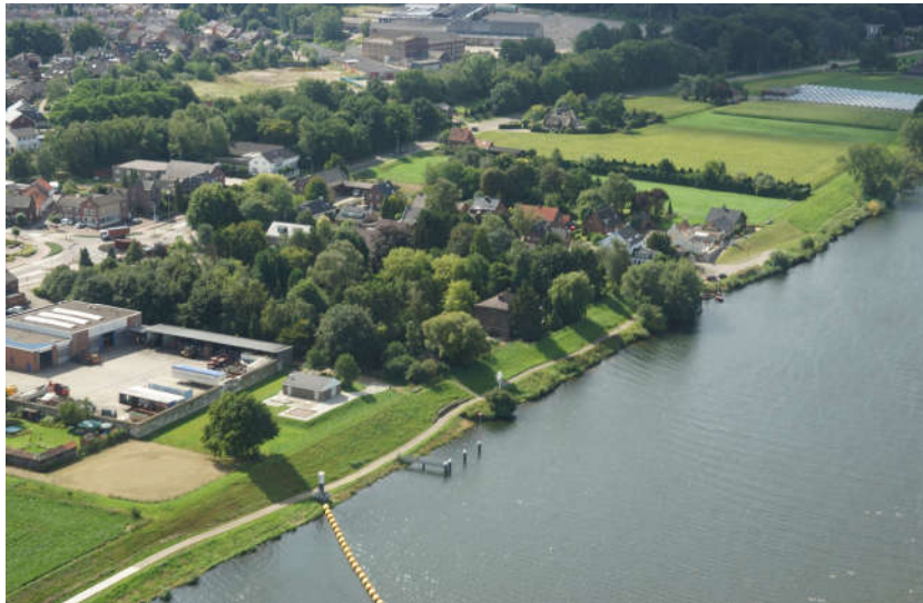
Figuur 3: Luchtfoto huidig dijktraject Belfeld
