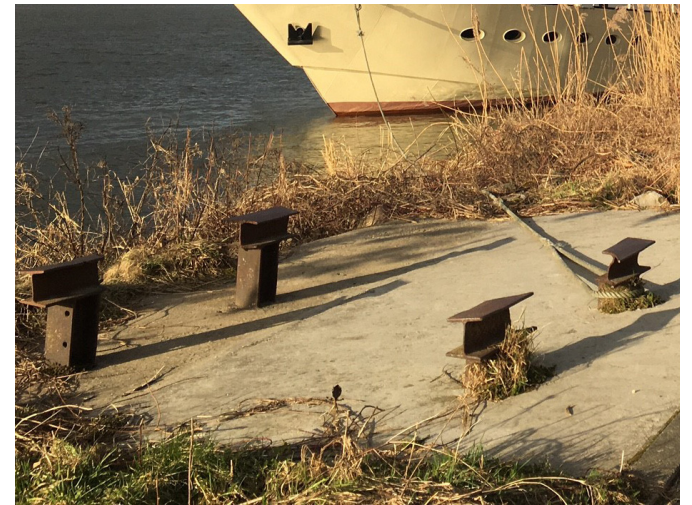
Van links naar rechts: loopbrug bij nr. 12 / bankje Ikea Duiven / stenen markering rivierkm 100 (boven) / bestaande aanmeervoorziening beton en staal (onder)
