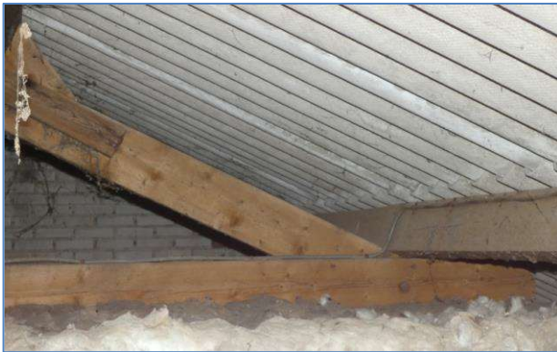
Foto 11 gedeelte gebouw 1 met glaswol-ventilatieplafond onder de kap
