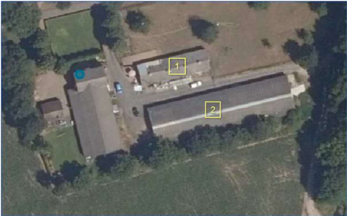
Figuur 1. Sloop van varkenstallen 1 en 2.
