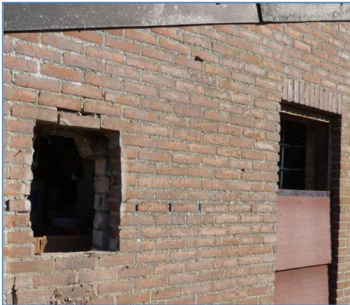
Foto 16 grote gaten in spouwmuren
