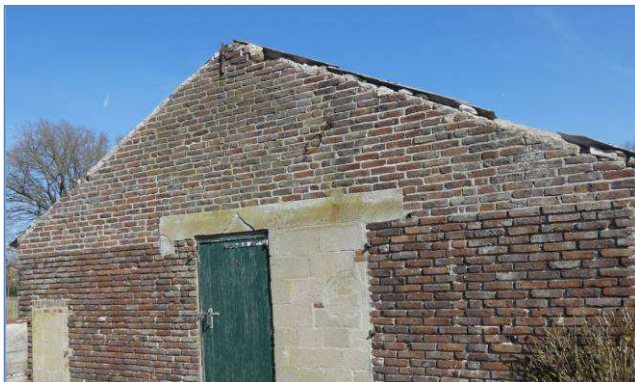
Foto 7 en 8 kopgevels gebouw 1 zonder overstekken of windveren
