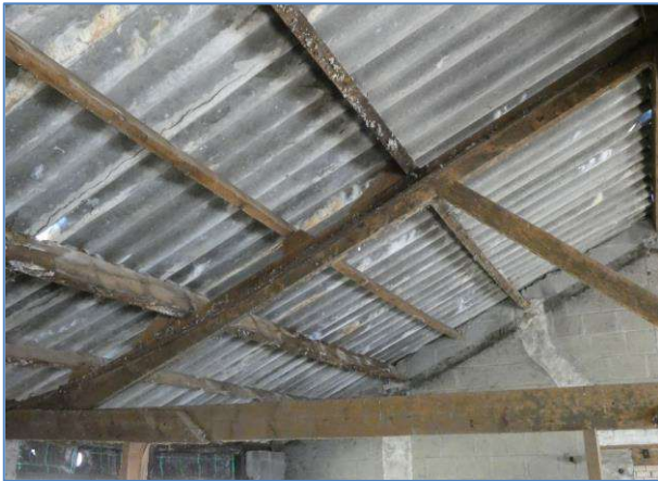
Foto 9 en 10 geen isolatie en grotere gaten in dak gebouw 1
