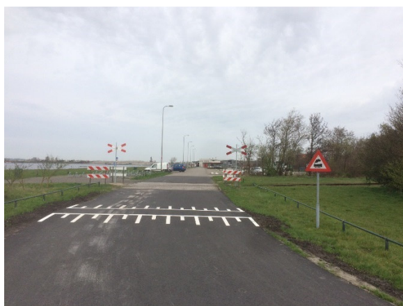
foto 3: opname oprit voor spoorwergovergang
