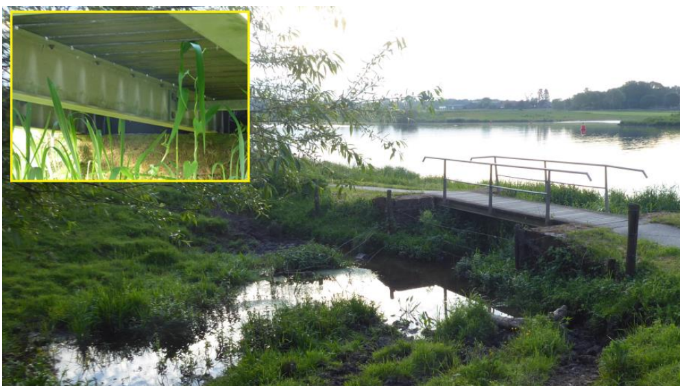
Afbeelding 3. Het bruggetje van de Molenkampweg, grenzend aan de Maas. Onder deze brug zijn geen nesten van grote gele kwikstaart aangetroffen.
