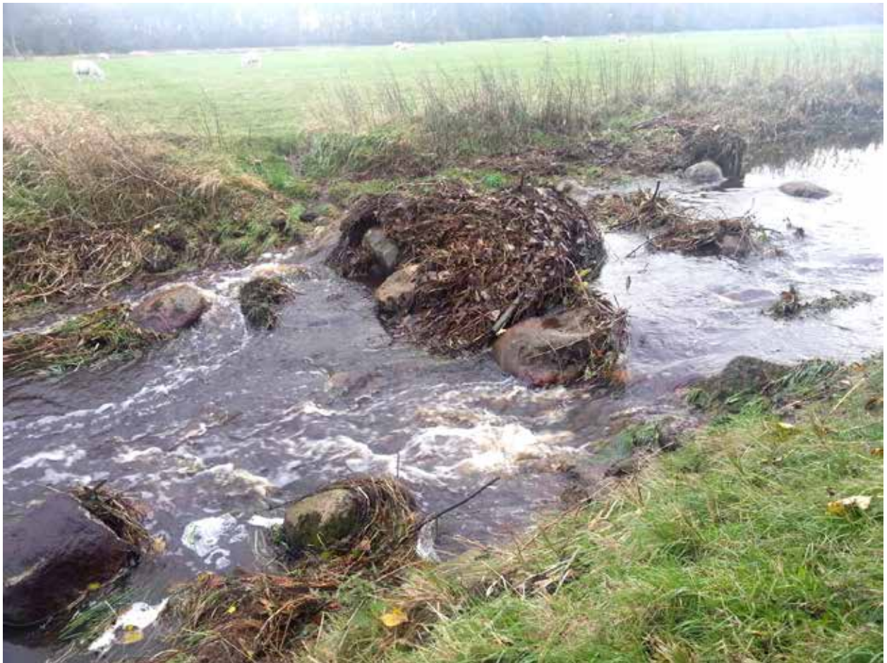
Figuur 11: Vispassage in het Dwarsdiep met veel plantenmateriaal waardoor stroomsnelheden binnen de vispassage toenemen. In het bovenliggende gebied zijn veelal ook KRW-maatregelen zoals hermeandering uitgevoerd. Dit gebied is in deze situatie minder toegankelijk voor vis.
