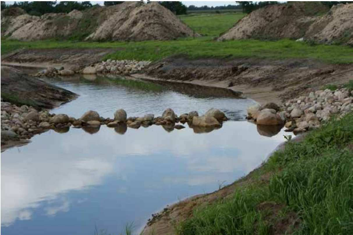
Figuur 4: Foto bekkervispassage Oostervoortsche diep (in aanleg)
