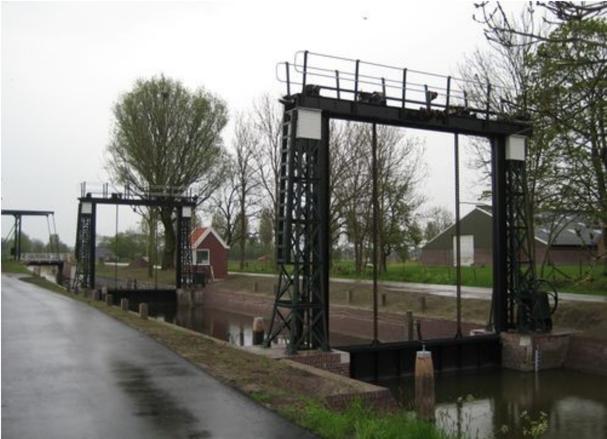
Figuur 6: Oosterdijkshornerverlaat, waarbij voorste deur op een kier staat en er een lokstroom wordt gecreëerd voor vissen die stroomopwaarts willen migreren.
