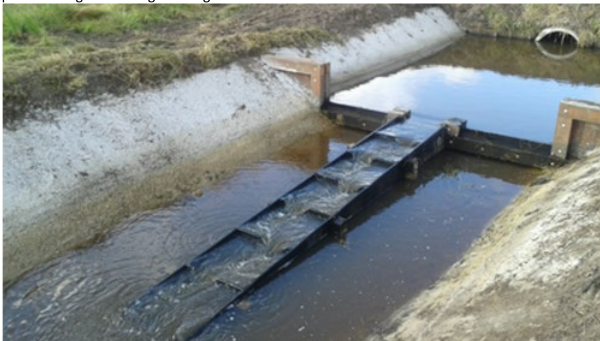
Figuur 5 Foto van bekkervispassage in de Runslot
