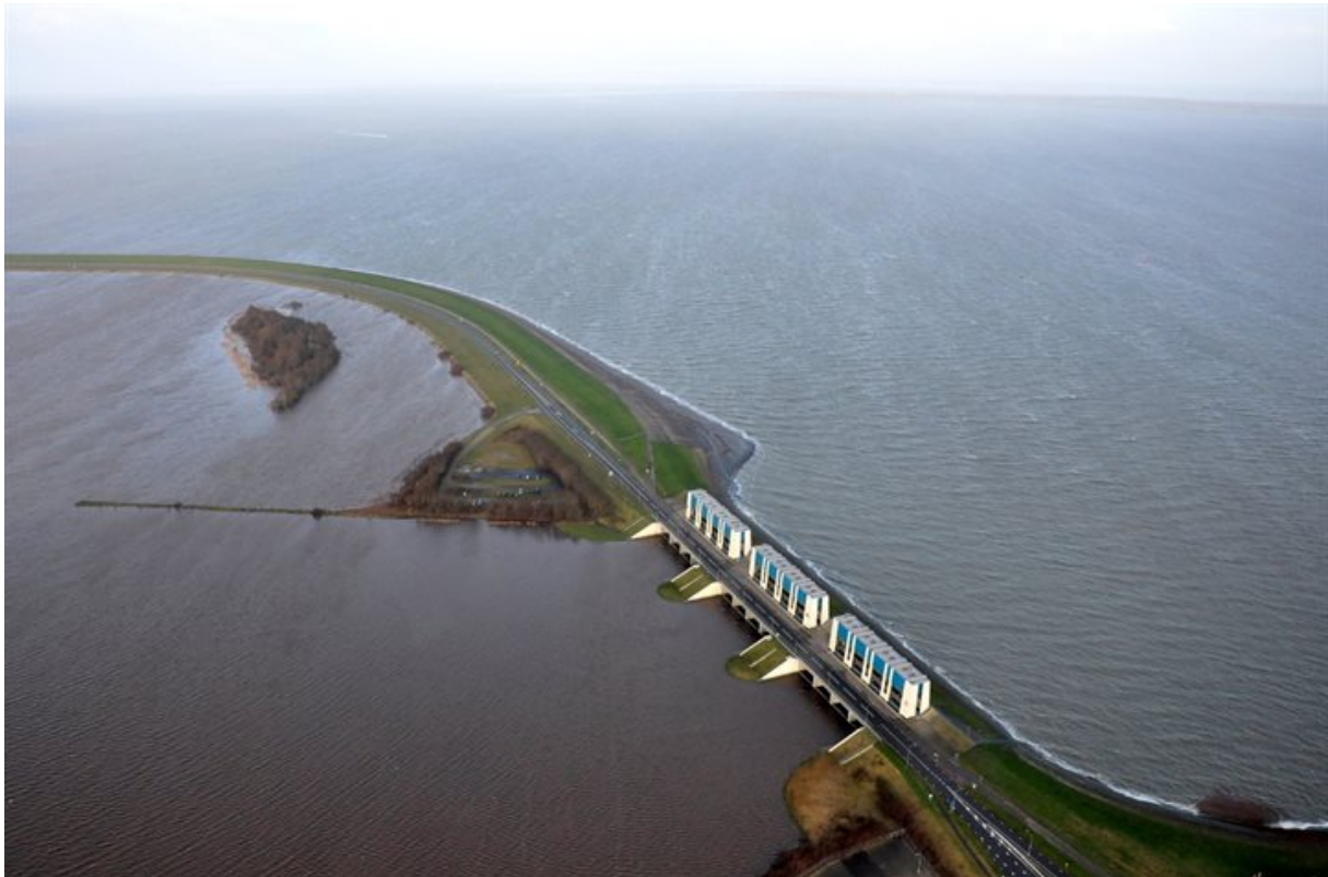
Figuur 12 luchtfoto Cleveringsluizen
