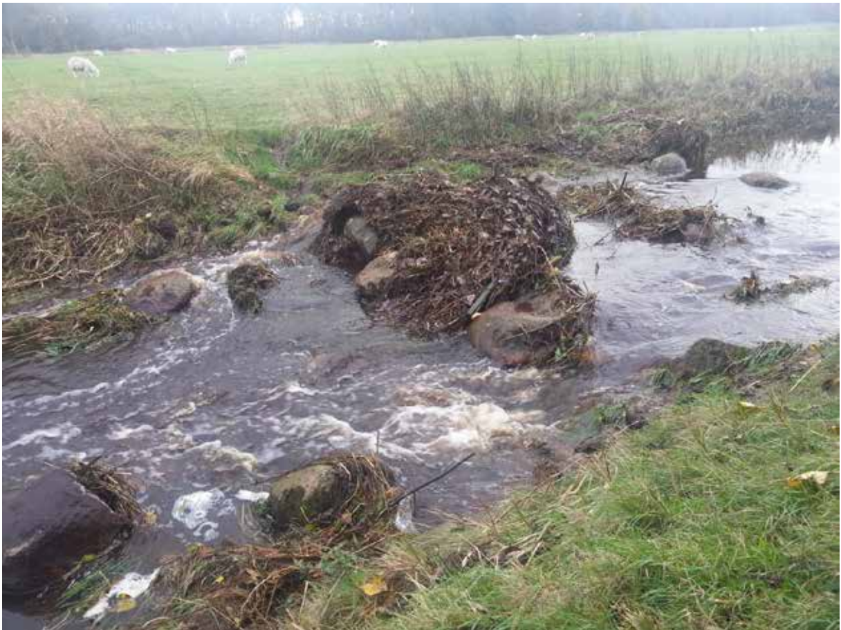
Figuur 1 Vispassage Dwarsdiep met drijfvuil
