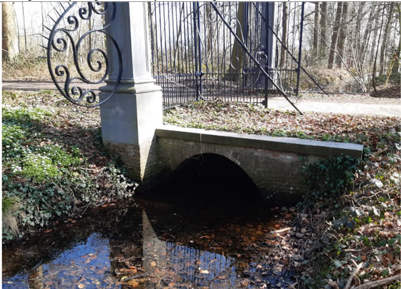
Maatregel 5: Verwijderen gemetseld muurtje uit duiker, vergroten doorstroomcapaciteit
