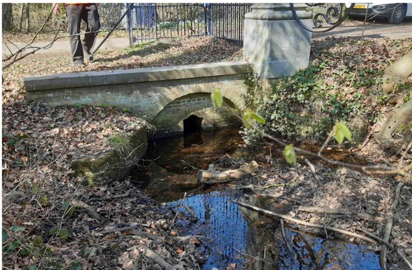
Maatregel 5: Verwijderen gemetseld muurtje uit duiker, vergroten doorstroomcapaciteit
