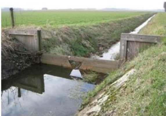
Figuur 8 Principeprofiel stuw
