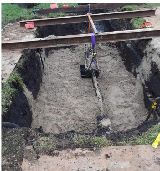
Figuur 1-4: Herstel mof 7, Ringdijk Bovenkerkerpolder nabij nr. 28
