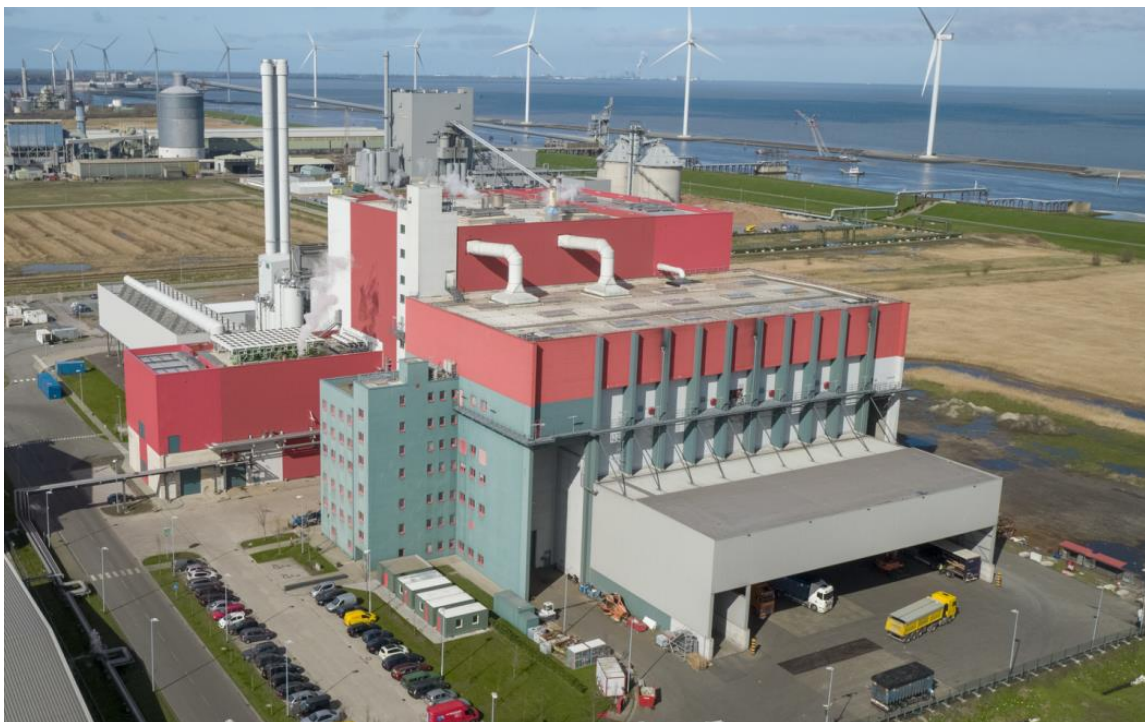
Afbeelding 1 Aanzicht van de installatie van EEW. Dit aanzicht kijkt op de bunker, met daarachter de afvalverbrandingslijnen, rookgasreiniging en schoorstenen.
