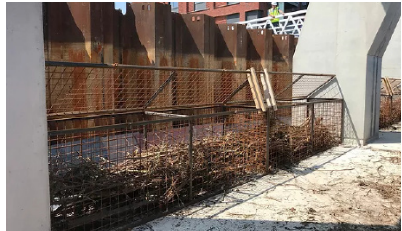
Uitvoering onderwaternatuur Amstelstroombrug - schanskorven
