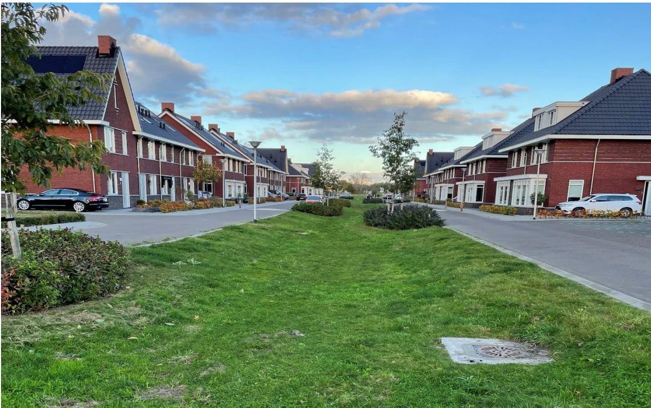
Figuur 6 Opvang van overtollig hemelwater via een wadi (Jaap Eden baan Haarsteeg)
