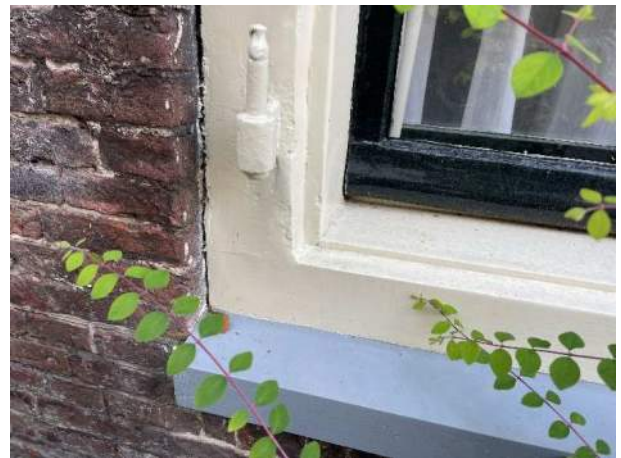
Nog aanwezige 'duimen' en luikspoonningen
