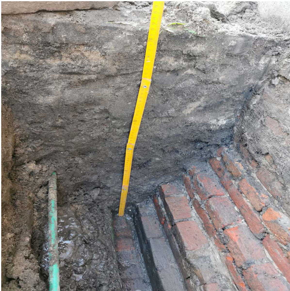
Figuur 3. Inspectiegat ter plaatse van bestaande fundering.
