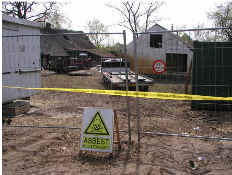
Figuur 17: Afscherming van een asbestverdachte locatie
