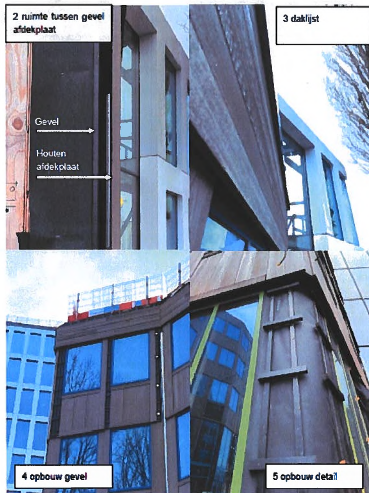
Figuur 3.6 De houten gevelijsten zijn zwevend aangebracht waardoor er achter de planken ruimte is waar vleermuizen gebruik van kunnen maken.
