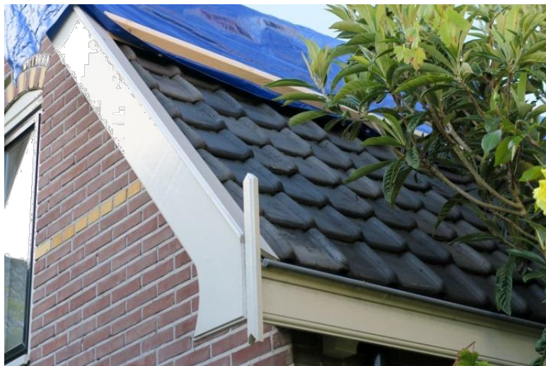
Detail dak schuur huidige toestand
