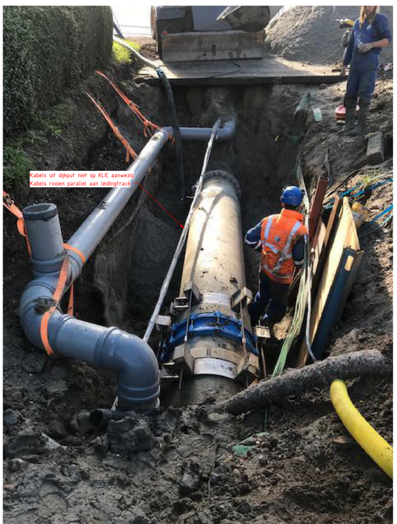
Foto 0622- reparatie effluentleiding 2019
