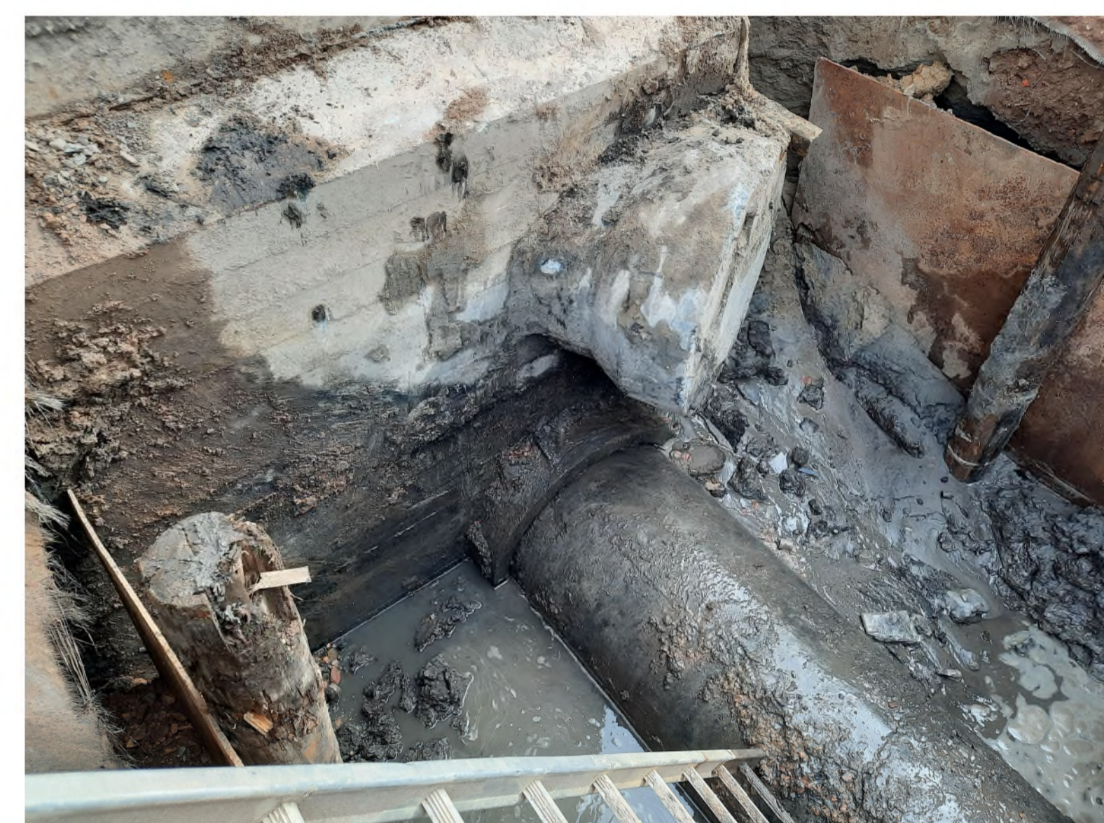
Foto 20220919_111339 - aansluiting zuivering - proefsleuf 2022 - locatie doorsnede 8
