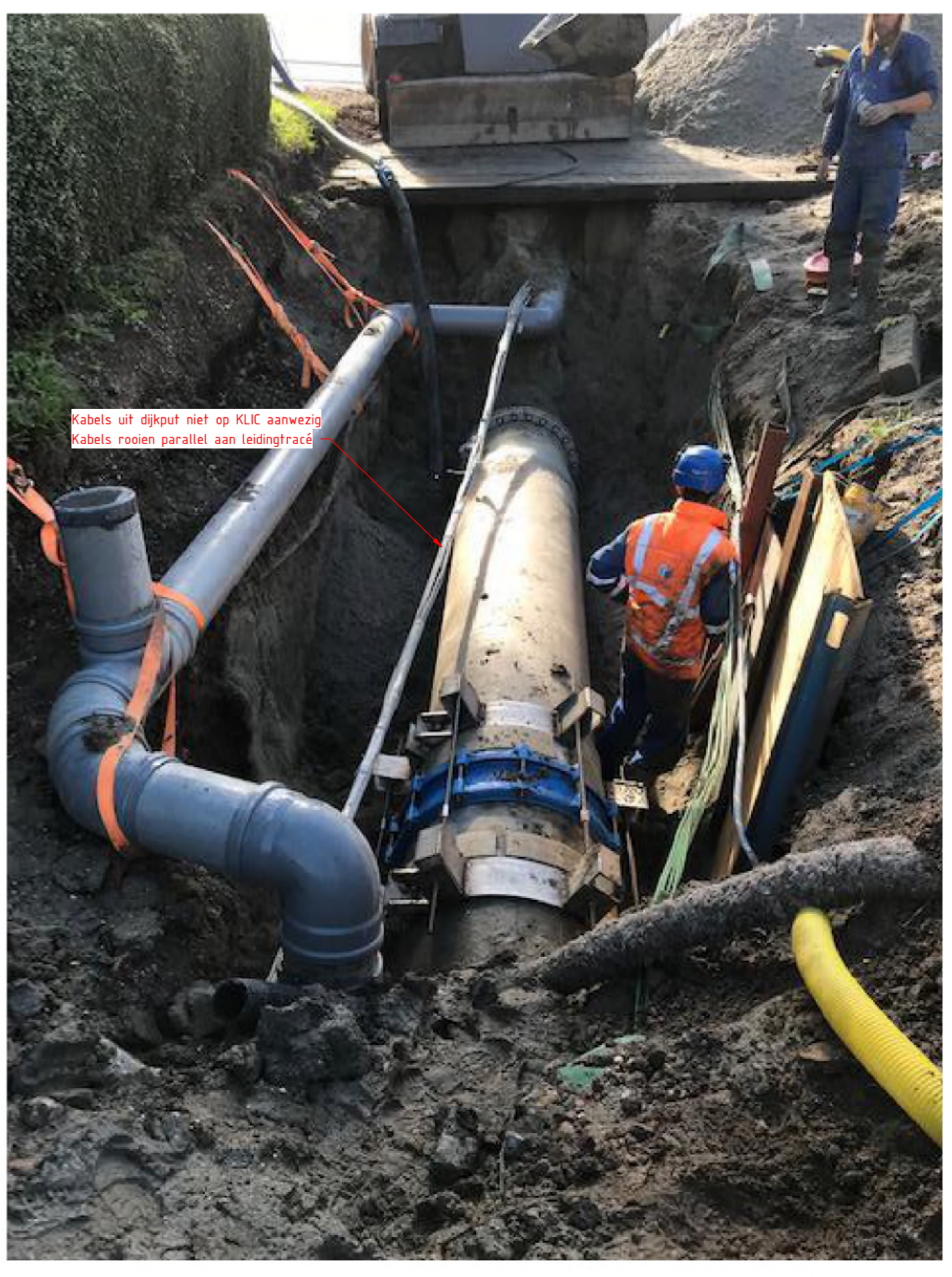
Foto 0622- reparatie effluentleiding 2019
