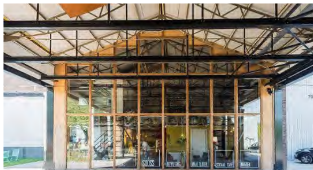
De binnengevels van de onderdoorgang zijn hoofdzakelijk transparant
