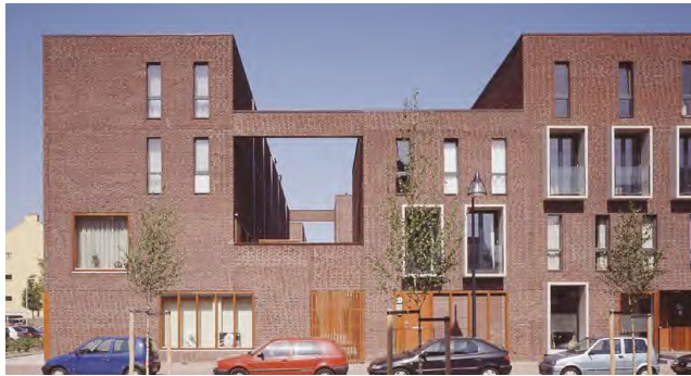
De hoeken zijn zo ontworpen met speciale hoekplattegronden en hoog opgetrokken doorlopende gevels dat het blok rondom een continue gevel krijgt
