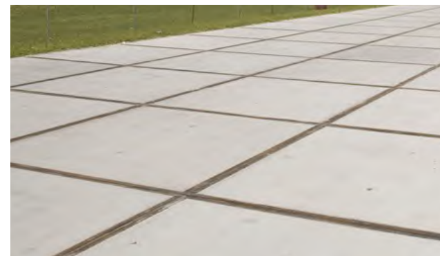
Betonplaten als stoere verharding, deels hergebruikt
