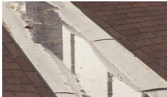
Waterafvoer via robuuste molgoot
