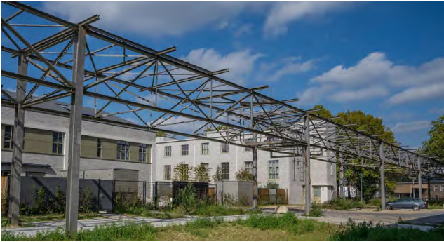
Oude constructies als relict in de openbare ruimte
