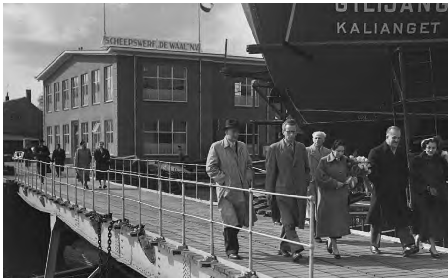
Historische foto van het directiekantoor, gelegen naast één van de scheepshelling van de werf
