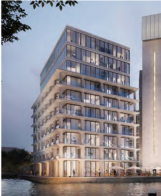
Gelaagdheid in de gevel geeft het gebouw meer zeggingskracht en breekt de hoogte van de toren
