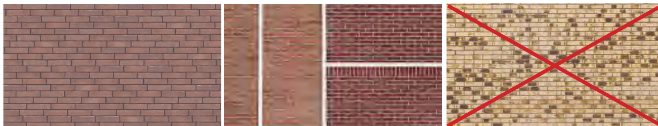
Een meer egaal baksteenpalet met subtiële nuances
