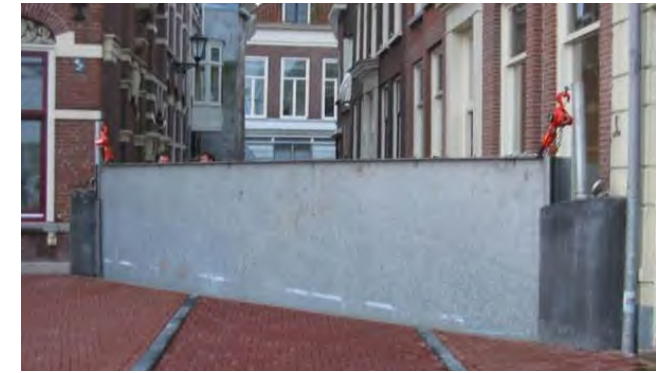
Voorbeeld tijdelijke waterkering, d.m.v. hefschuif
