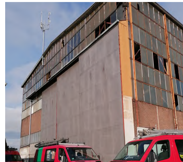
Elementen van de bestaande hal: grote deuren, bakstenen plint, ragfijn gedetailleerde glazen bovenbouw
