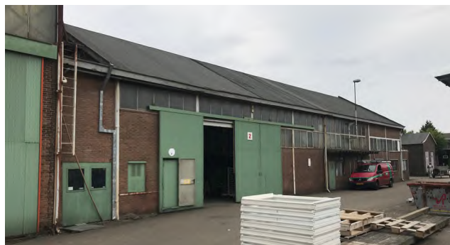
Bestaande shedloods: gevel aan de kraanbaanzijde
