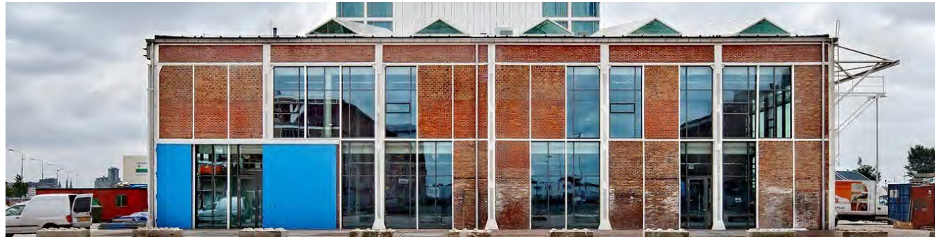
De rigiditeit van het grid wordt verzacht door een variatie in vullingen in het grid, zowel in materiaal als compositie
