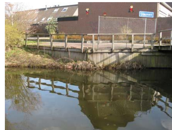
KA009: Vlasdonk Vervangen damwanden.
