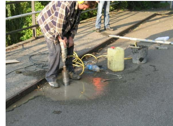
Het nemen van boorkernen t.b.v. nader onderzoek
