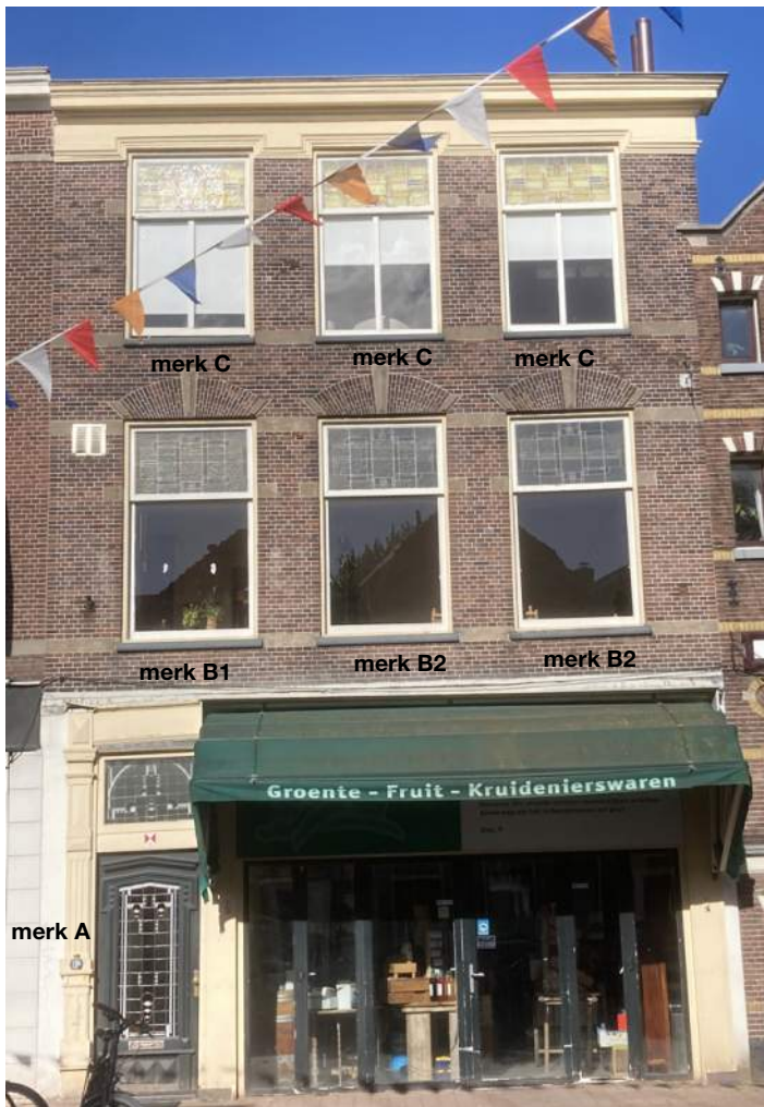
Voorgevel met kozijn merken
