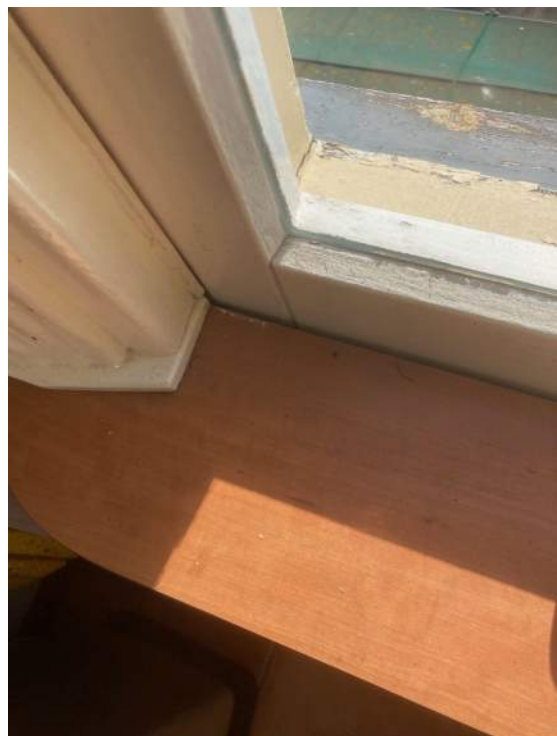
foto binnenzijde Kozijnmerk B1
