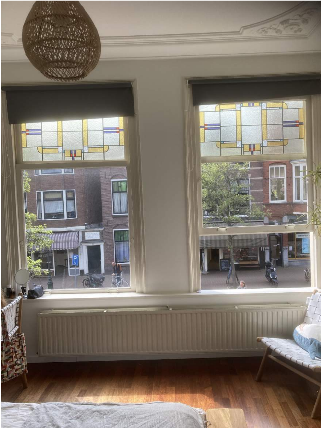
foto binnenzijde Kozijnmerk B2
