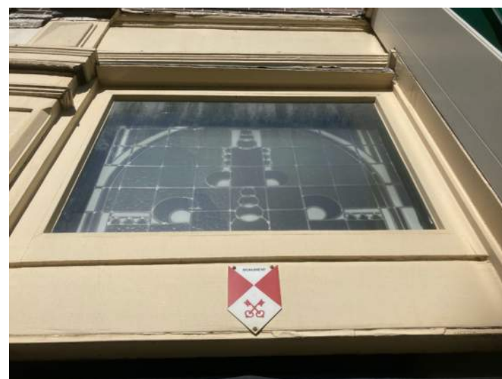
foto bovenlicht met voorzet bovenraam
