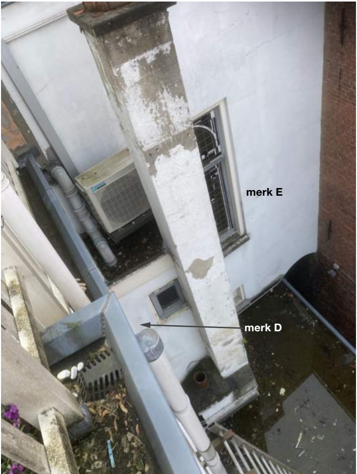
Achtergevel met kozijn merken
