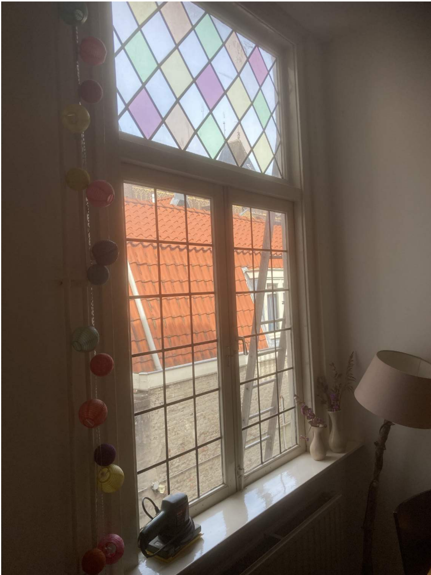
foto binnenzijde Kozijnmerk D
