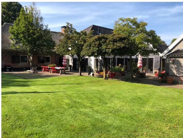
bouwplek gezien vanuit “noordoost” zijde
