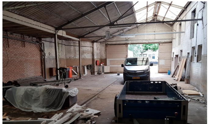
Foto 4: westelijk gedeelte voormalig bedrijfsgebouw (vanaf zuidzijde)
