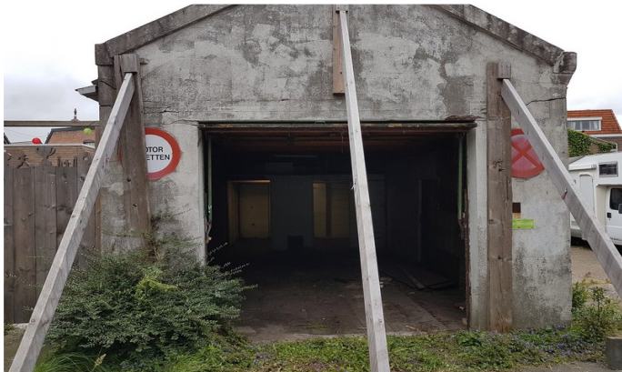
Foto 3: noordoostelijk gedeelte voormalig bedrijfsgebouw / voormalig ketelhuis (vanaf noordzijde)
