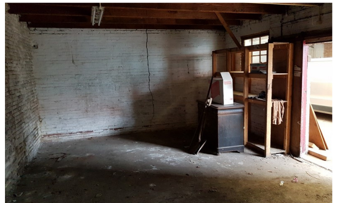
Foto 6: zuidoostelijk gedeelte voormalig bedrijfsgebouw
