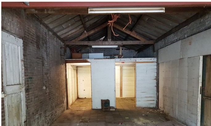
Foto 5: noordoostelijk gedeelte voormalig bedrijfsgebouw, in pandig (vanaf noordzijde)
