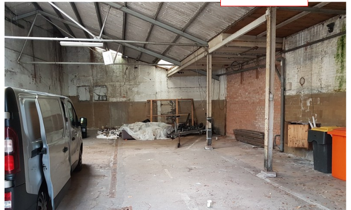
Foto 2: westelijk gedeelte voormalig bedrijfsgebouw (vanaf noordzijde)
