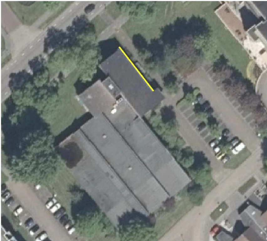
Figuur 1: Nestplaatsen van gierzwaluw en van huismus bevinden zich in de met een gele lijn aangegeven gevel. Bron achtergrond: PDOK.
