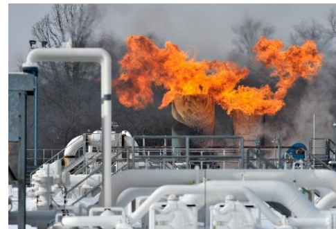
Figuur 3: Voorbeeld van een gasexplosie
