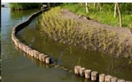
Soort beschoeiing: palenrijbeschoeiing functie: behoud doorstroomprofiel
