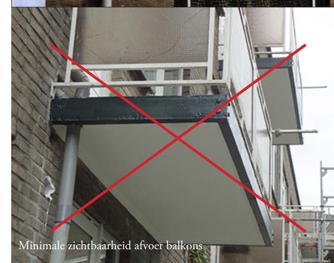
Geen zichtbare goot, maar verhullen goot
